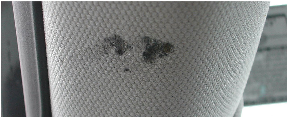
Дупка във вътрешната облицовка
