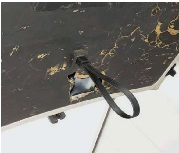
Силно повредена вътрешна облицовка
