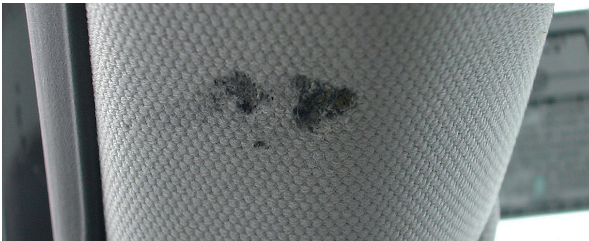
Дупка във вътрешната облицовка
